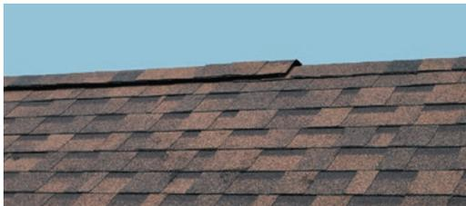
本品は、大棟・隅棟をリッジウェイ屋根材と同質素材で仕上げる専用部材です。統一感ある仕上がりは屋根全体に独自の雰囲気を醸し出します。製品本体にミシン目が入っており、非常に早く施工する事ができます。
